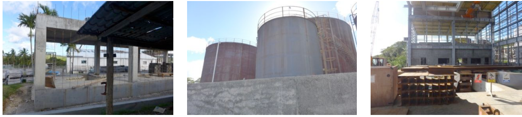
図 66 ディーゼル発電機 2 台を増設中のアイメリーク発電所
