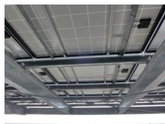
PV モジュール外観 4
