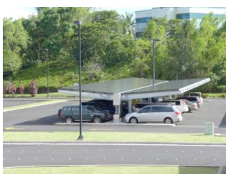
PV モジュール外観 2
