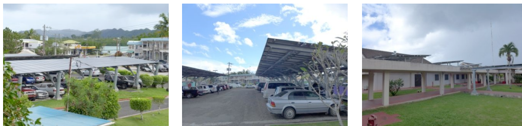
図 62 ベラウ国立病院の PV システム設置状況
