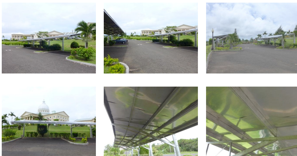
図 10 連邦政府庁舎の PV システム設置状況
