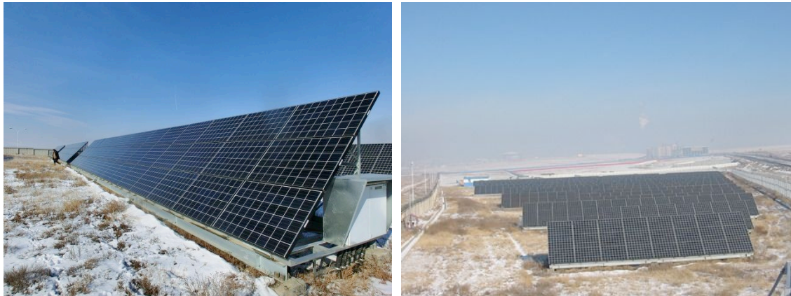
図 49 モジュール設置状況
