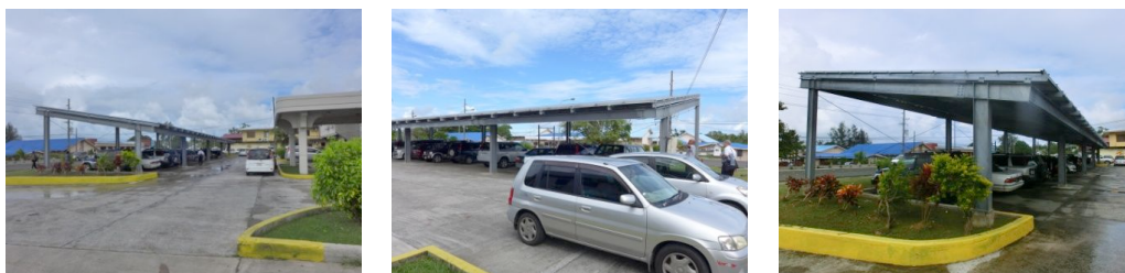
図 58 教育省の PV システム設置状況(モジュール概観)
