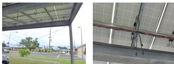
図 60 教育省の PV システム設置状況(外されたケーブル)
