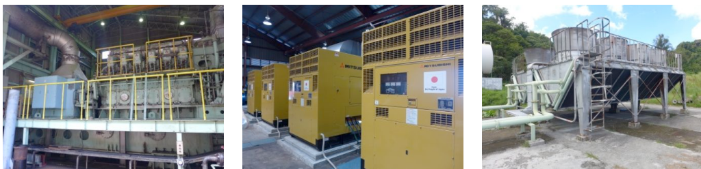
図 65 パラオ（コロール）の系統電力のほとんどを依存するマラカル発電所
