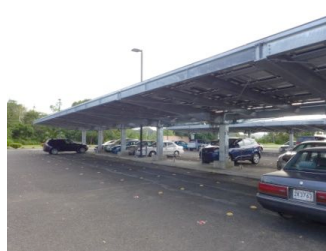
PV モジュール外観 3
