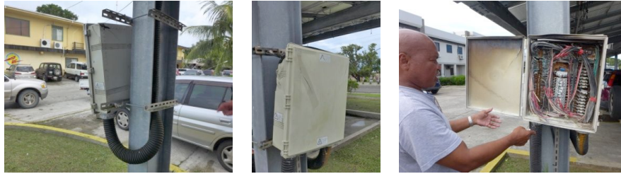
図 61 教育省の PV システム設置状況(燃焼した接続ボックス)
