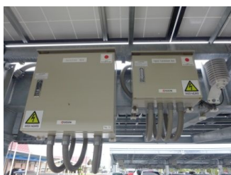
接続箱, 変換器
