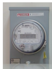
電気メーター
