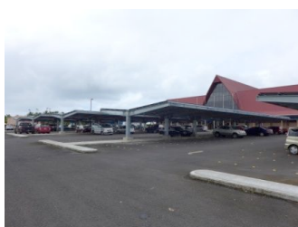
PV モジュール外観 1
