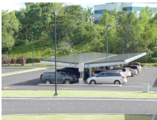
図 18 パラオ空港駐車場の PV モジュール外観
