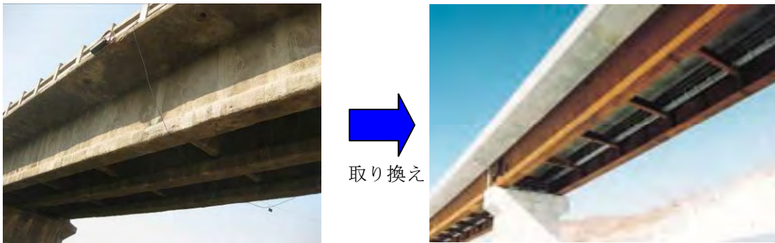
既設 RC 主桁 (Shetrunji 橋)
