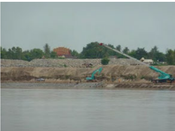
対岸（タイ側）の施工状況
