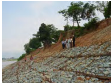
ボケオ県の工事現場の様子（2012年5月）
