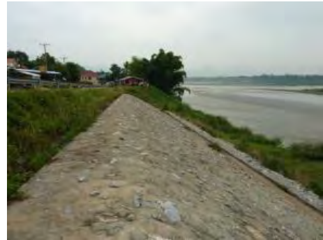
道路保全のための護岸
