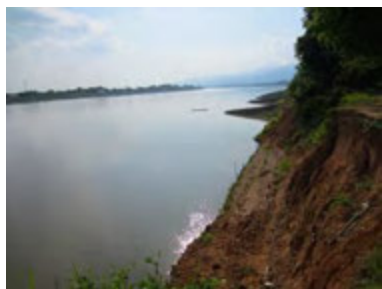
ボリカムサイ県の工事予定地（2012年5月）
