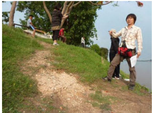
2008年洪水後の盛土
