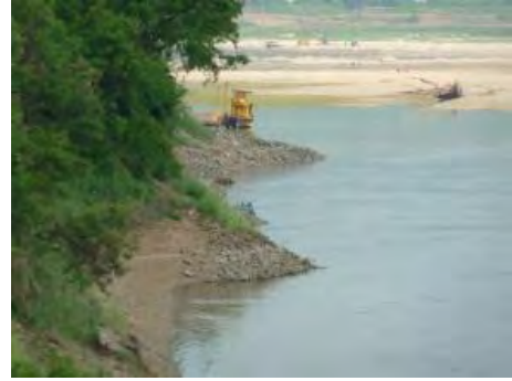
タイの石炭業者による石積水制工
