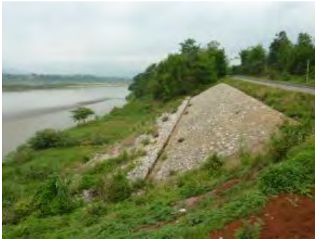
道路保全のための護岸
