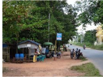
図 6.2.3: アクセス道路南側写真
