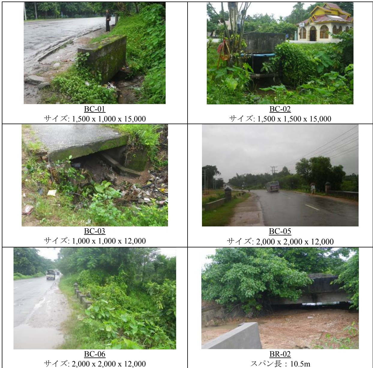
図 5.5.11 : 既存のボックスカルバート及び橋梁
