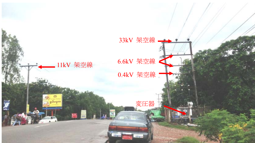
図 4.2.12 : 既存架空電力配線および変圧器の例
