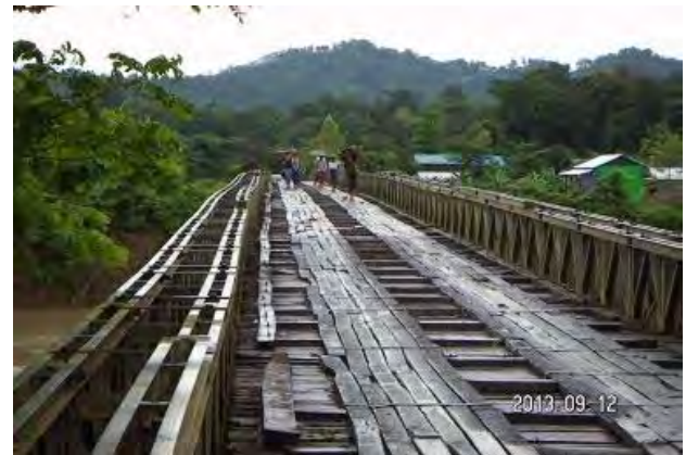
タンルウェ橋 (トングアップからマエイ間)
