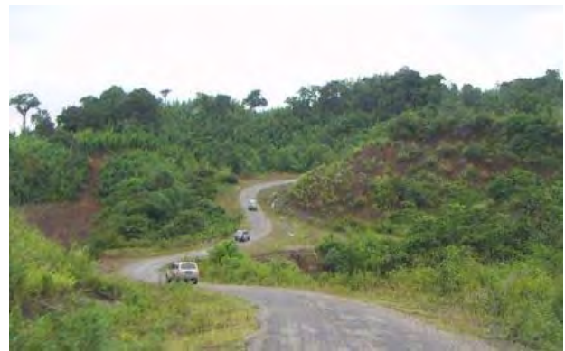
道路状況② マエイからアン間対象道路の様子
