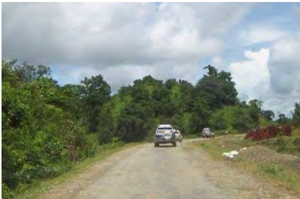
道路状況① トングアップからマエイ間対象道路の様子
