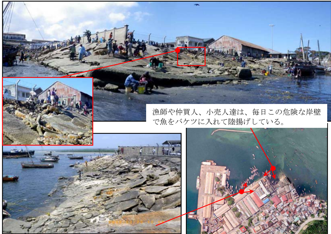
図 2-10: スロープ式係船岸の現況
