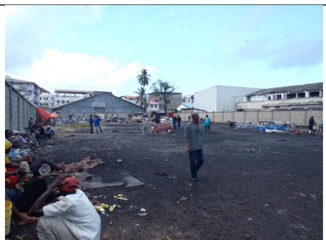
【写真-10】陸上施設建設サイト 建設サイト内部の状況
