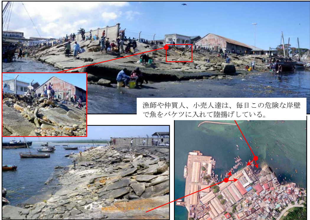
図 2-10: スロープ式係船岸の現況
