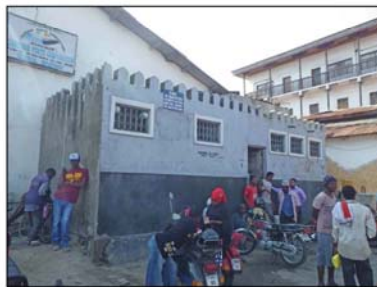
⑦: トイレ棟-1
