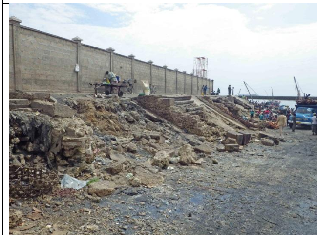
【写真-09】マリンディ漁港(スリップウェイ側) 崩落した護岸の状況
