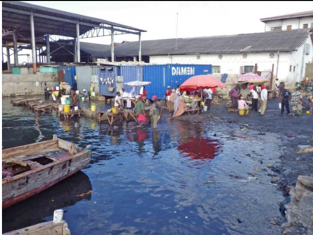
【写真-17】マリンディ漁港(スリップウェイ側) 満潮時では加工台、販売台が海水に浸かっている
