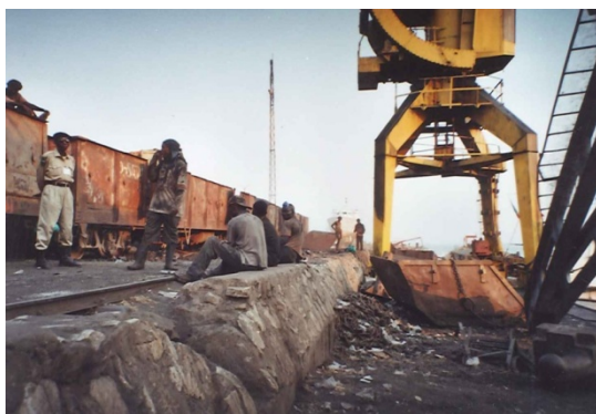
Photo 3.48: Dual Elevation Wharf (Kalemie)
