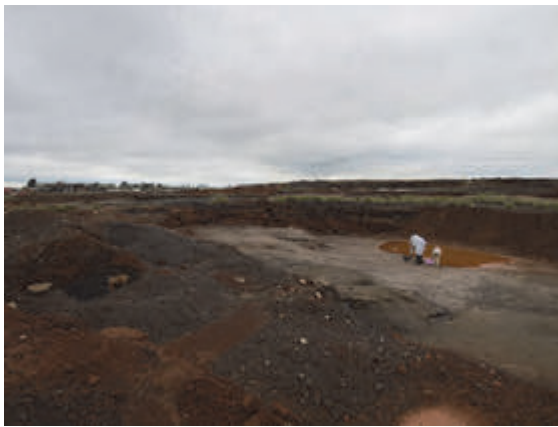
写真 4.51 旧尾鉱ダム（閉山時に鉱滓や 廃さいが埋め戻されている）
