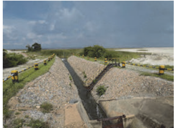
写真 4. 36 尾鉱ダムの放水路 (迂回水路に直接排水)
