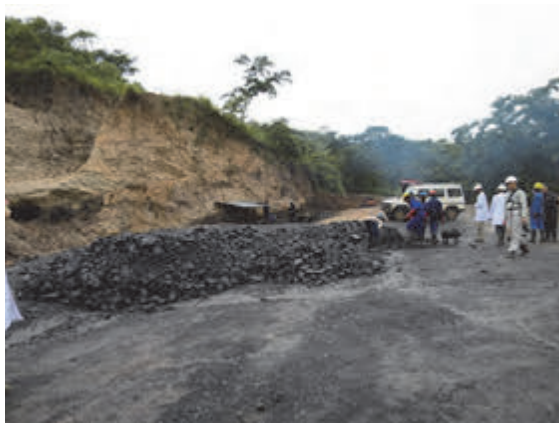
写真 4.9 坑口（横坑）状況
