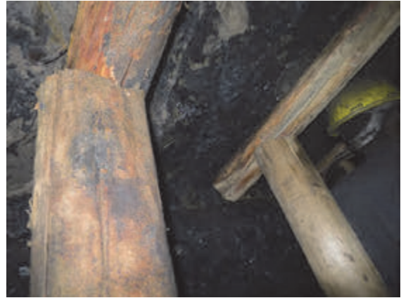
写真 4.24 横坑内天盤状況
