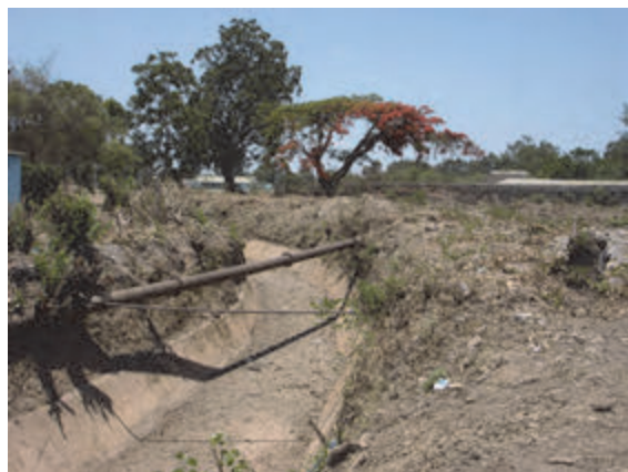
写真 3.10 カブウェの鉛亜鉛鉱山の排水路跡 (付近の土壌は汚染されているとのこと)
