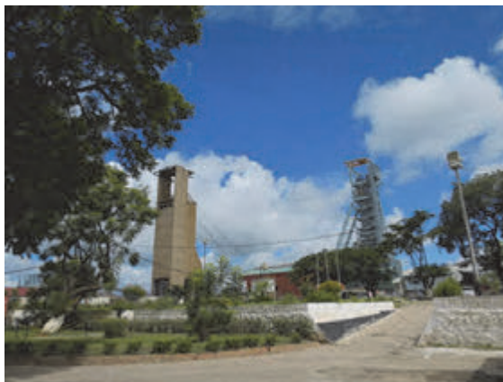
写真 4.41 Konkola 鉱山立坑 (左側が原鉱運搬用)
