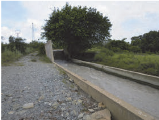
写真 4. 35 鉱山施設からの放水路 (尾鉱ダム迂回水路に直接排水)
