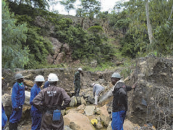
写真 4.5 旧坑口からの坑廃水流出 と坑口上部の崩壊
