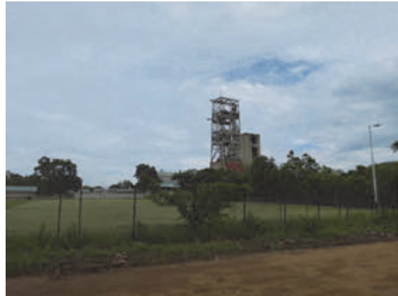
写真 4.34 Mopani 鉱山の立坑
