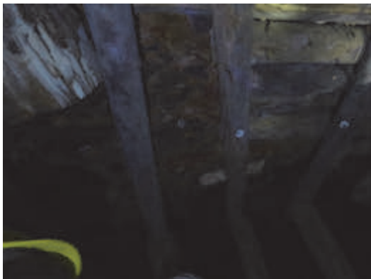
写真 4.25 横坑内天盤支保状況
