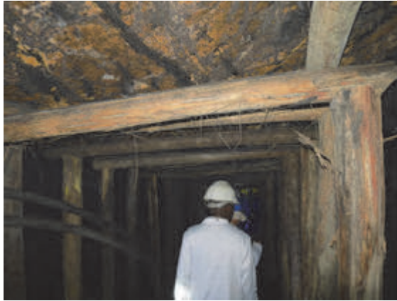
写真 4.23 横坑内支保状況
