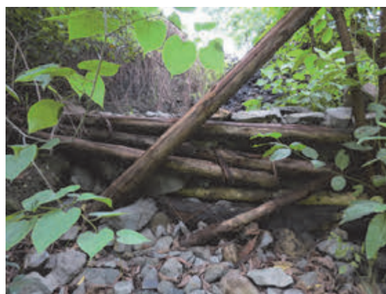
写真 4.4 原鉱ストック下の石積みによる排水フィルター
