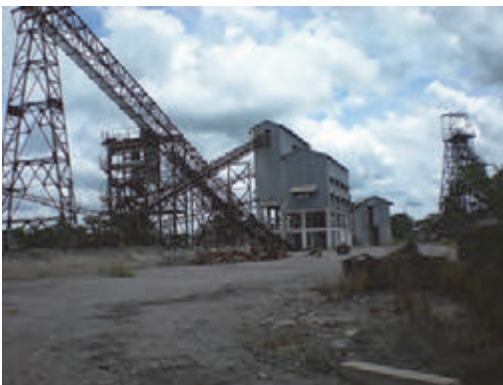
写真 3. 26 一次粗砕設備
