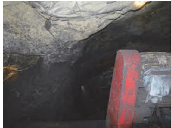
写真 4.22 Mchenga 鉱山横坑内天盤
