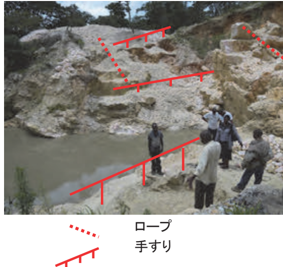
図 5.4 採掘現場での安全策
