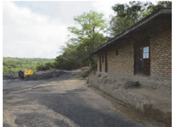
写真 4. 12 鉱山事務所と貯炭場
