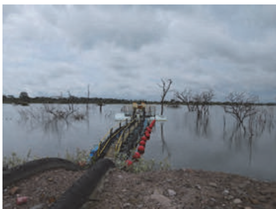
写真 4.45 尾鉱ダム内からの採水 （一部地域の生活等用水として利用）
