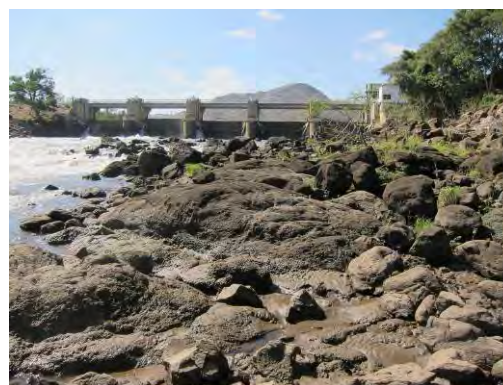
写真－4：取水口予定地
