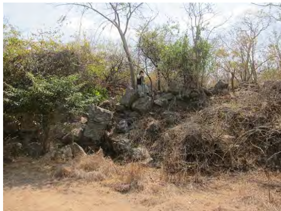
写真 2-3 既設水路上の巨礫築堤
