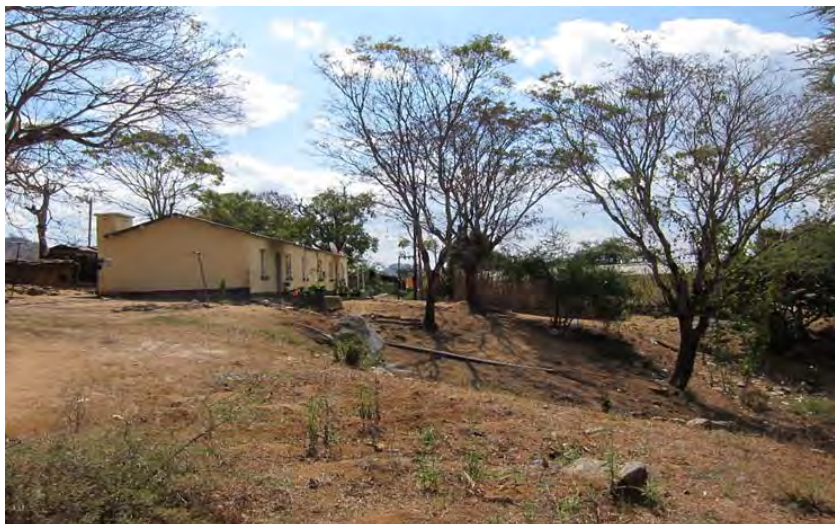
写真 2-11 導水路建設計画地周辺山側にある ESCOM 職員宿舎
