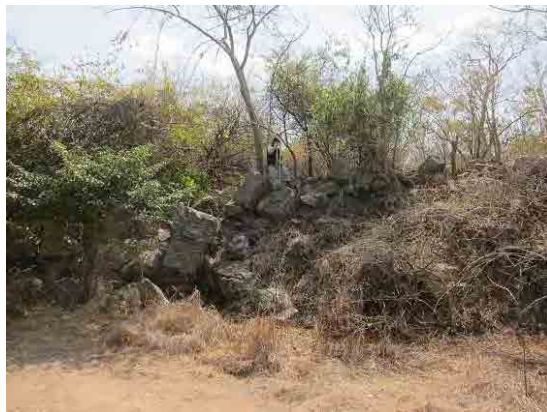
写真 2-3 既設水路上の巨礫築堤
