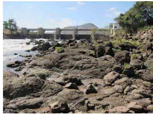
写真－４：取水口予定地
