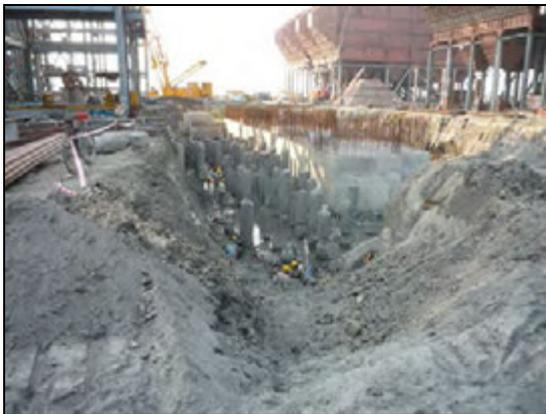
図 4.4-5 ミルバンカー杭基礎の施工
