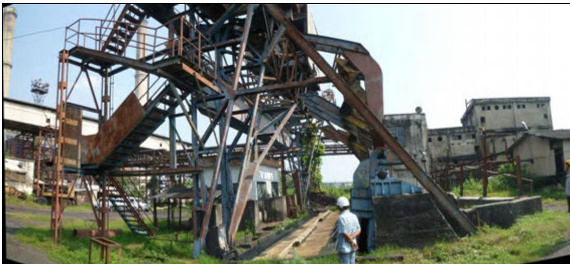
図 3.1-5 ワゴンティップラー（石炭アンローディング設備）
