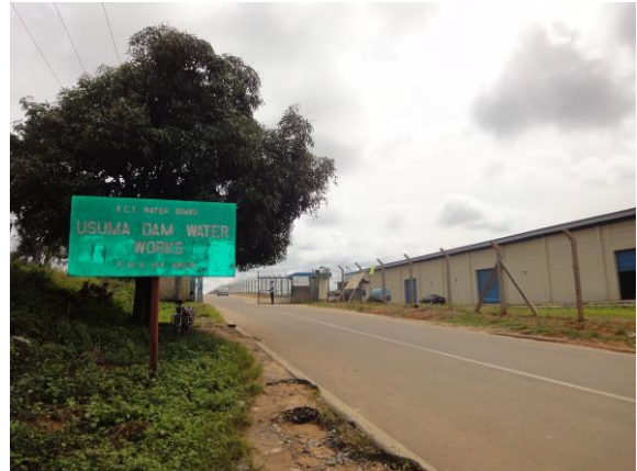
ウスマダム浄水場
