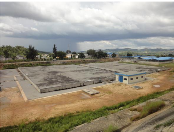
太陽光アレイ用地(3号及び4号タンク上部)
