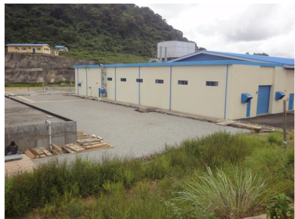
パワーコンディショナー建屋用地
