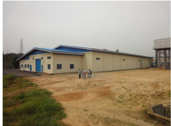
本計画の資器材の仮置き場
