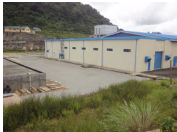
パワーコンディショナー建屋用地
