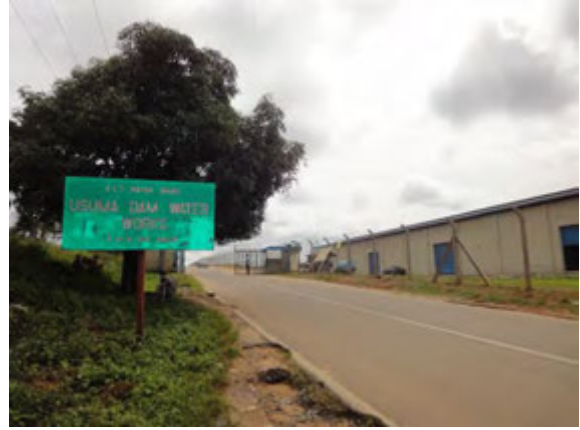
ウスマダム浄水場
