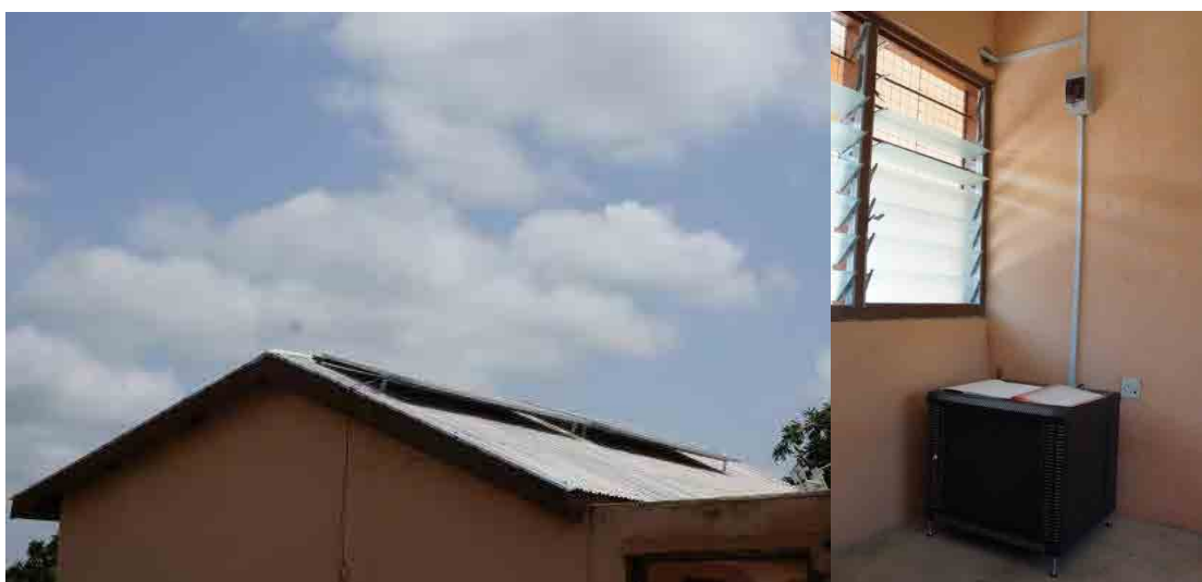
写真 48 PV パネル設置(左)、蓄電システムへの配線(右)
