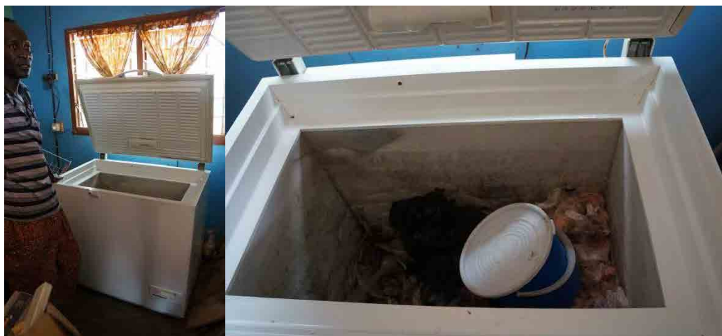
写真 30 ソーラー発電と DC 冷蔵庫を用いたコールドフード販売
