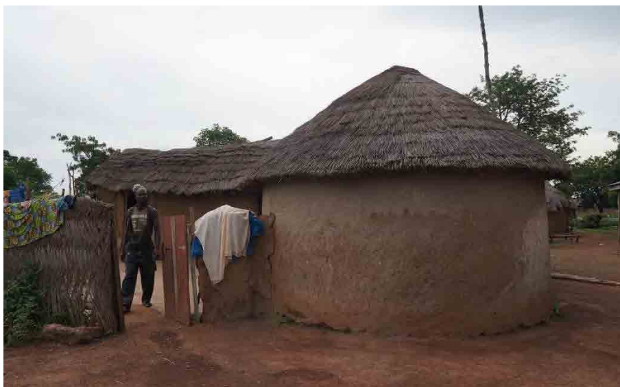
写真 35 Puriya におけるパイロット電力サービスの拠点
