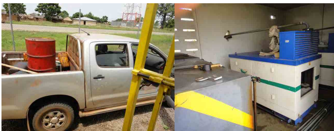
写真 28 電波塔に電力供給するための発電機(右)と日々の燃料供給(左)
