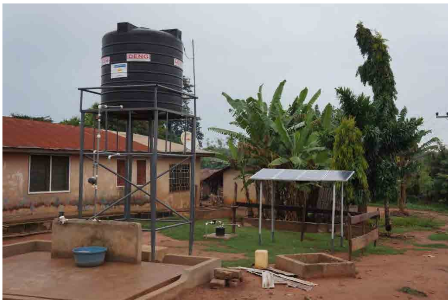
写真 26 ソーラー発電による水道サービス、Brong-Ahafo 州
