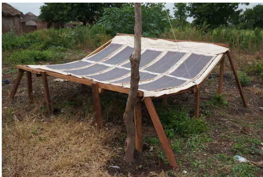
写真 43 PV パネル設置 (Puriya)
