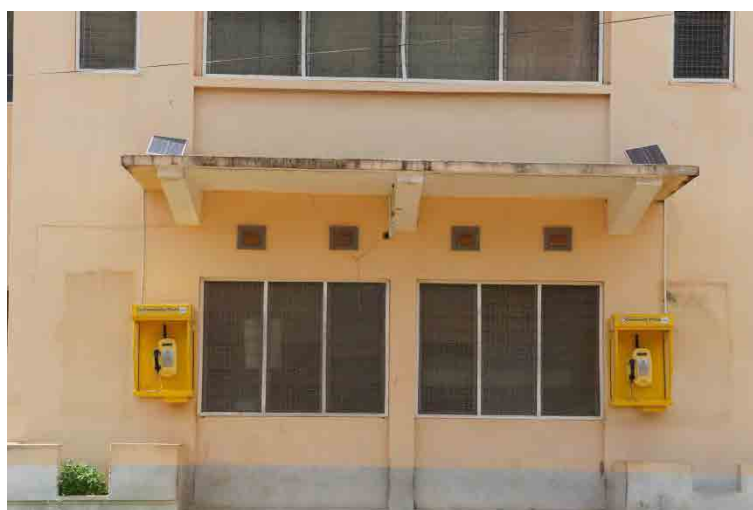
写真 13 ソーラー発電による携帯公衆電話 (MTN)
