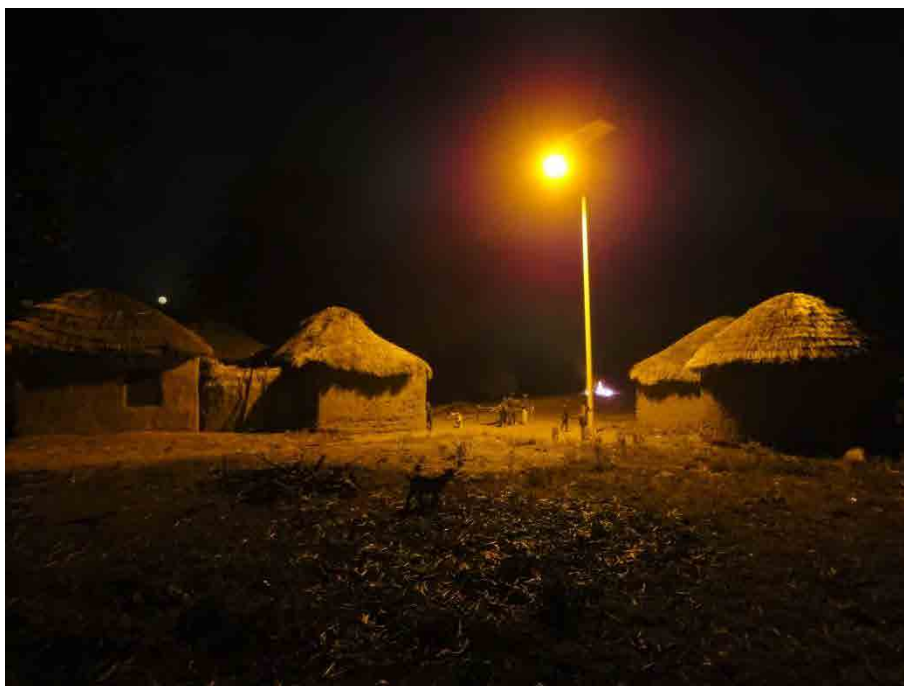
写真 8 無電化コミュニティでのソーラー街灯点灯の様子、Northern 州
