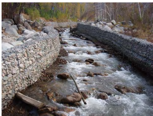
図 10.7 フトンかごによる流路工
