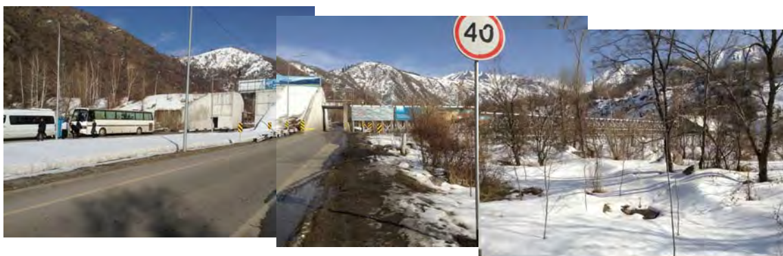
メデウダム下流に位置する鋼製スリットダム（下流側から）
