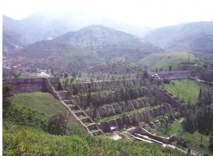
図 10.8 大アルマティ流域の既設砂防ダム
