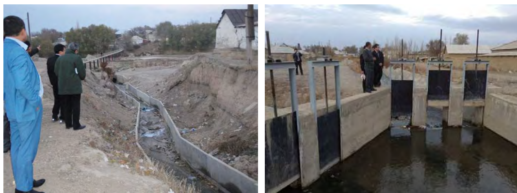
図 9.5 シムケント市郊外の洪水災害復旧状況（排水路と調整ゲートの設置）
