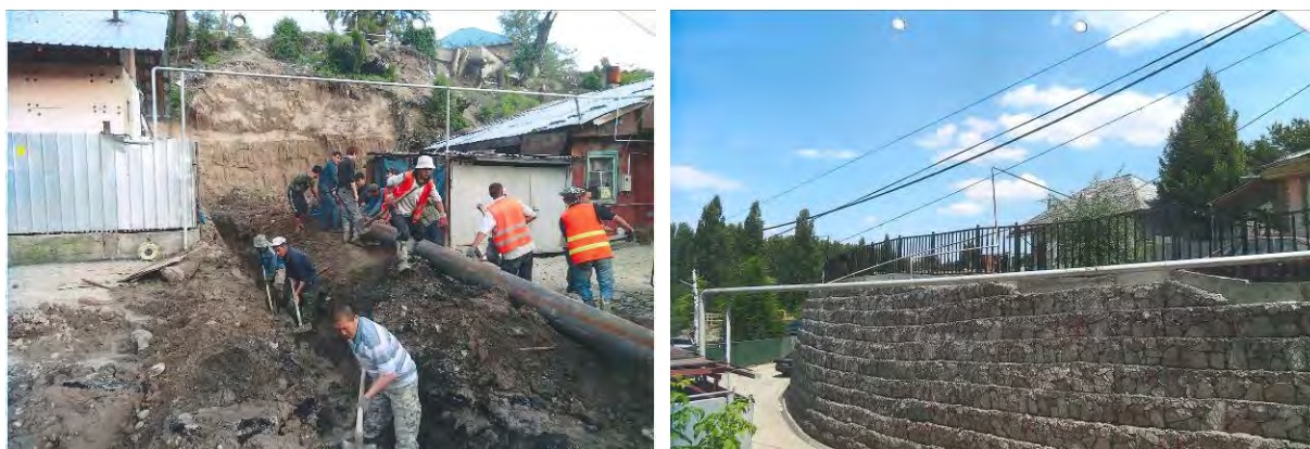
図 10.10 フトンかごの擁壁による急傾斜地の崩壊対策（左：施工中、右：施工後）
