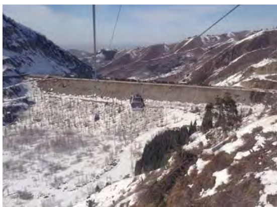
メデウダム（上流側から望む） （H=250 m、1973 年完成）
