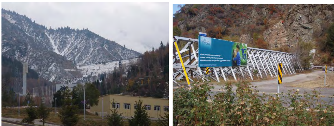
図 10.4 小アルマティ流域の砂防ダム（左：メデウダム、右：鋼製枠砂防ダム）
