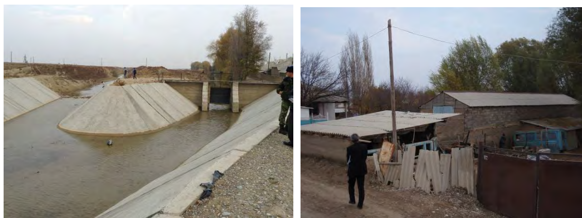
図 9.6 オルダバス地区の運河改修状況（左：護岸工と小型堰、右：浸水被害を受けた家屋）
