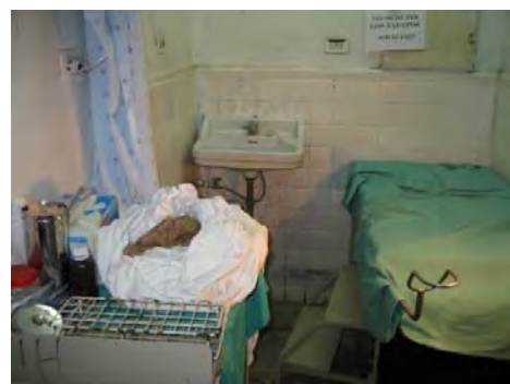
旧県病院建屋内の診察室。老朽化から劣悪な環境下 での診療が行われている。設備や医療機材の不具合 が多い。
