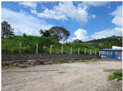
レンピラ県レパエラ市プロジェクトサイト。 既存 CMI 側から日本側協力対象サイトを見る。前面 の柵及び右手側倉庫の解体は先方負担工事となる。
