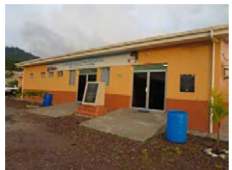
レンピラ県レパエラ市プロジェクトサイト。 既存 CMI は米州開発銀行により 2012 年に建設。同ク リニックが提供していない保健医療サービス部分を 日本側工事とし、機能連携を図る。
