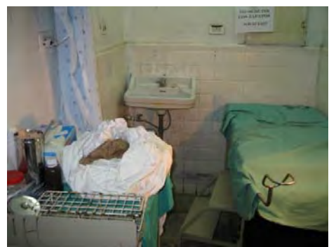
旧県病院建屋内の診察室。老朽化から劣悪な環境下 での診療が行われている。設備や医療機材の不具合 が多い。
