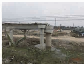
写真 3-21(桁上の型枠材)
