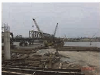
写真 3-1(ニンビン橋梁)
