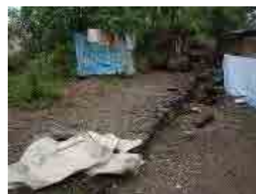
2.8km 左岸の旧堤防
