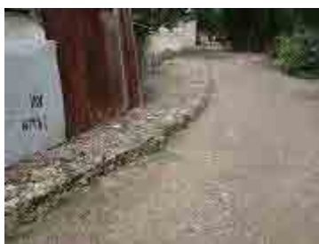
1.9km 左岸の旧堤防
