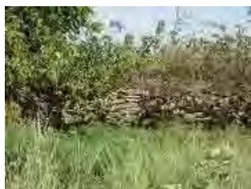
0.7km 左岸の旧石積み護岸
