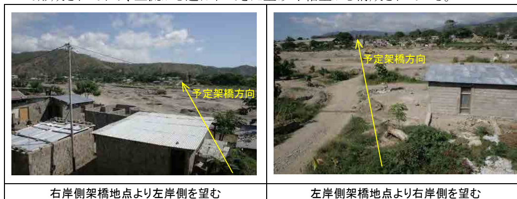
写真 架橋予定位置周辺の状況
