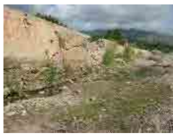
護岸前面の損壊
