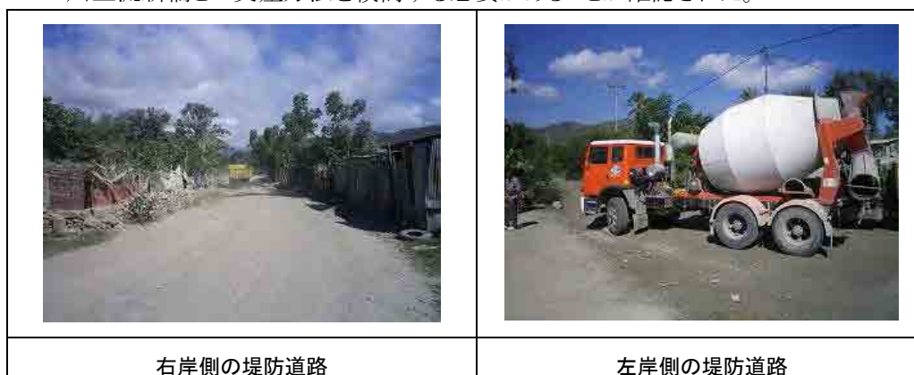
写真 右左岸の堤防道路
