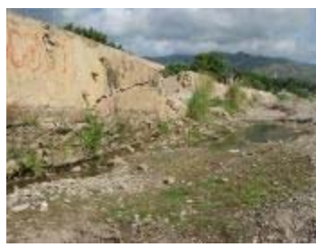
護岸前面の損壊
