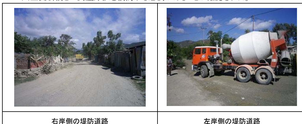
写真 右左岸の堤防道路
