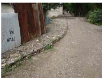
1.9km 左岸の旧堤防
