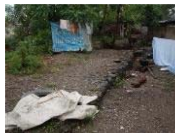
2.8km 左岸の旧堤防
