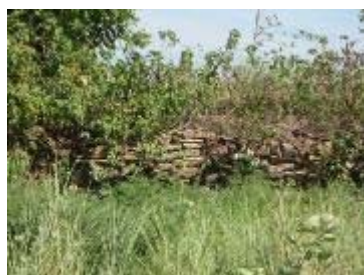
0.7km 左岸の旧石積み護岸
