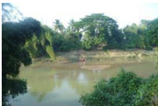
RO17-a Ramgarh (Sabroom) の Feni 川橋梁（北方面の写真）
