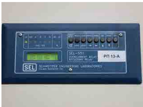
図 5-7 保護リレー装置（アメリカ SEL 社製、一部 DGR リレーを具備、-40 度対応 10 年保障）
