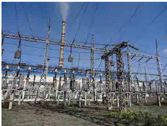
第4火力発電所鉄構
