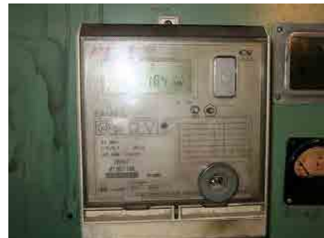
図 5-13 内部の遮断器 (A 系統・B 系統)
