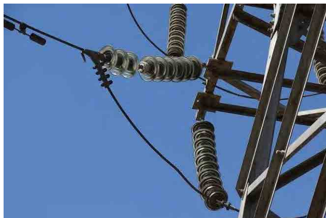
図 4-4 110 kV BARUUN 変電所引込鉄塔のがいし
