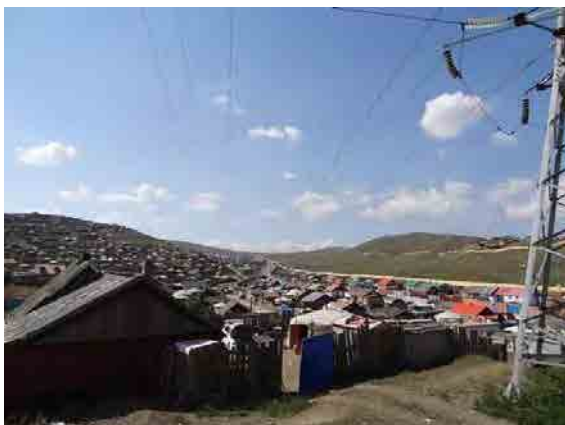
UMARD 変電所分岐点(第4火力発電所側)
