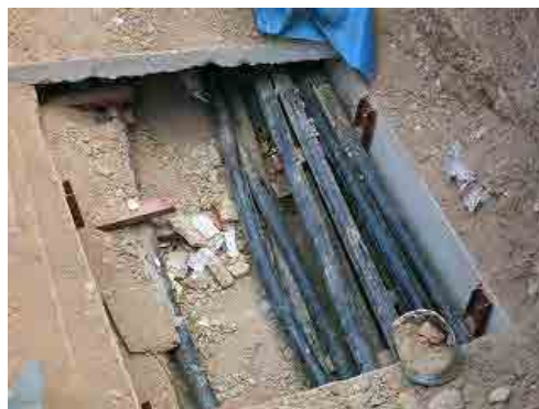
図 5-3 地中配電線設備例
