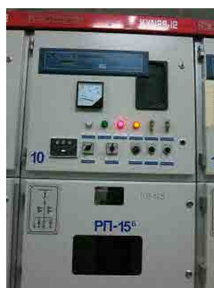
図 5-6 配電用遮断器（中国製、右列が 10 kV、左列が 6 kV、室内にはヒーターが設置）
