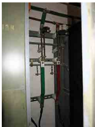
図 5-14 断路器 (負荷開閉器能なし)
