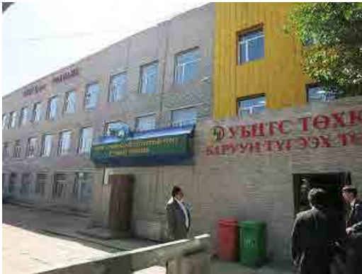
図 5-26 西地区配電センター
