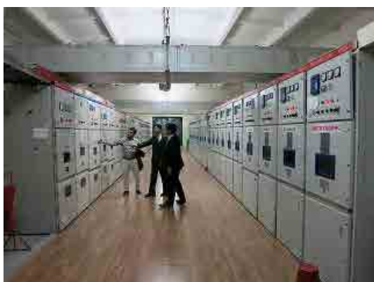
図 5-6 配電用遮断器（中国製、右列が 10 kV、左列が 6 kV、室内にはヒーターが設置）
