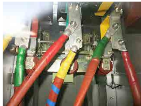
図 5-9 フィーダのケーブル端末 (ロシア製)
