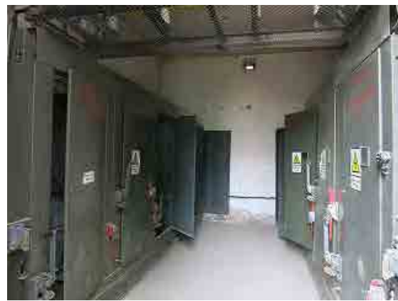
図 5-13 内部の遮断器 (A 系統・B 系統)
