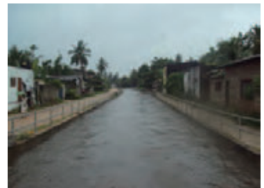
事業実施後の排水路
