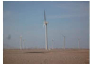
本事業により建設された風力発電所
