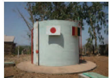
管路系給水施設の給水タンク
