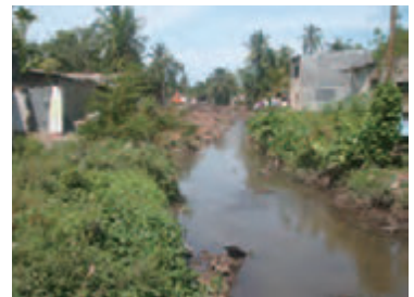
事業実施前の排水路（2002年撮影）
