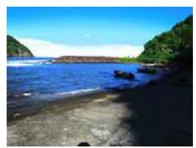
同 既存防波堤
