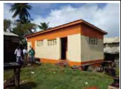
既存トイレ棟（新設）
