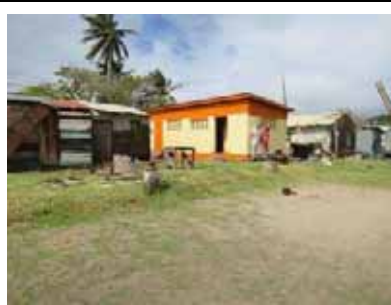
同 既存バラック施設
