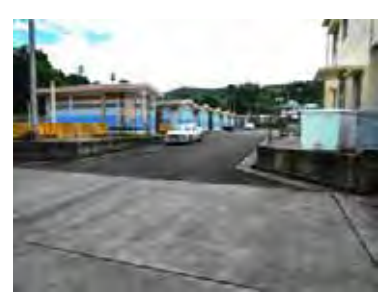
同 漁民ロッカー棟とセンター棟
