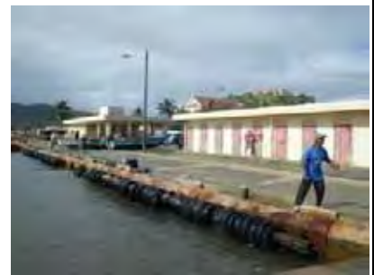
同 漁民ロッカー棟
