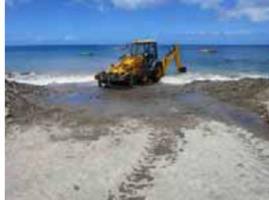
同 スリップウェイ上の堆石除去作業
