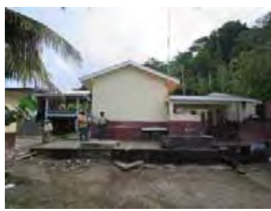
同 海側から見た施設
