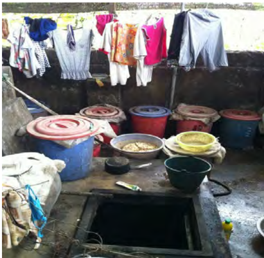
北部農村で普及しているコンクリート貯水槽
