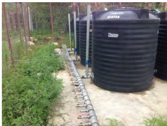
図 3-50 CWS の給水タンクと接続管
