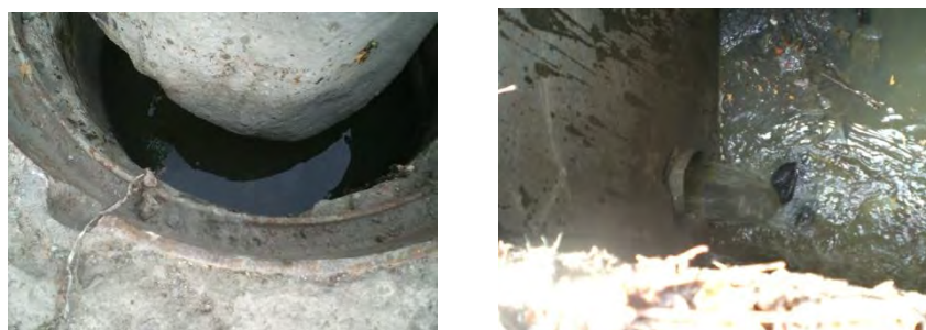
図 4-33 マンホール内の高水位（左図）及び下水管からの汚水越流状況（右図）
