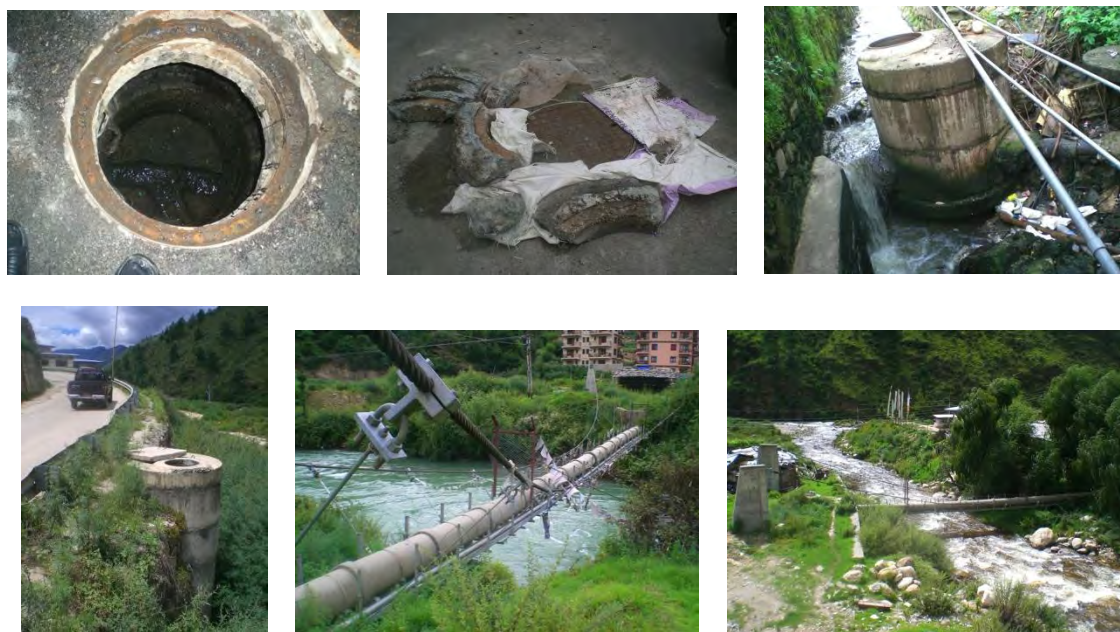
図 3-56 一連の下水管路施設（各種マンホール及び河川横断管路橋）
