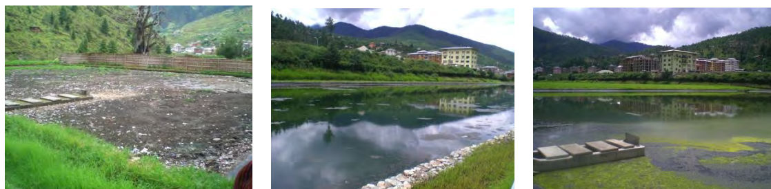
図 3-53 Babesa 下水処理場の嫌気性池(左)、通性池(中)、熟成池(右)
