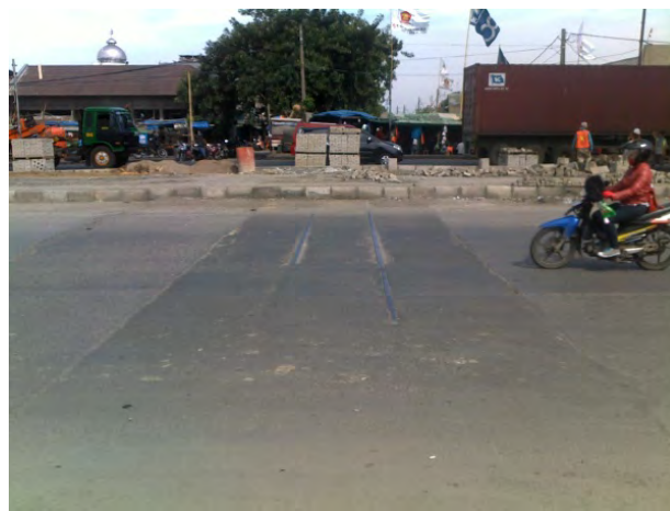
図 2.5.5 地点 B の現況 (線路が埋め殺し状態)
