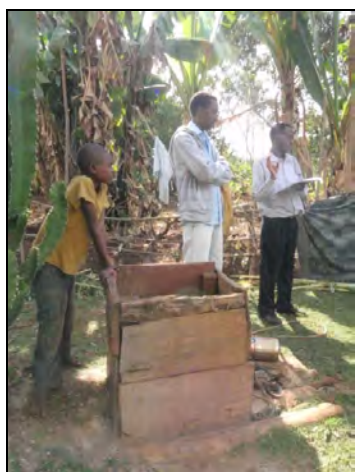
上部が木枠構造の個人用手掘り井戸
