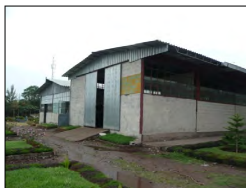
セラムアワサ技術職業訓練校の建屋 （一部）
