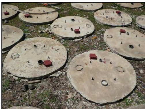
塩素投入口つきスラグ
