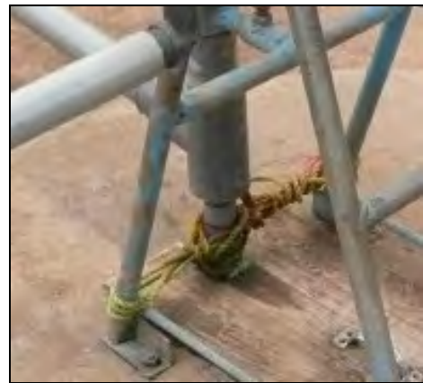
羽目板と PVC 管をロープで固定
