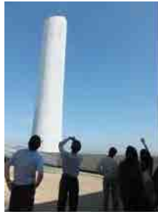
超々臨界技術を採用した礫子火力発電所で煙突を見学する招聘者。同技術の開発途上国での導入可能性について意見が交わされた
