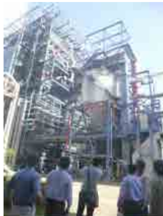
礫子火力発電所の排煙脱硫装置。環境負荷を大幅に低減した技術に関心が集まった
