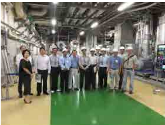
東京スカイツリーでは、東京ソラマチ等の複合施設や周辺地域への熱供給を行う地域冷暖房設備を視察
