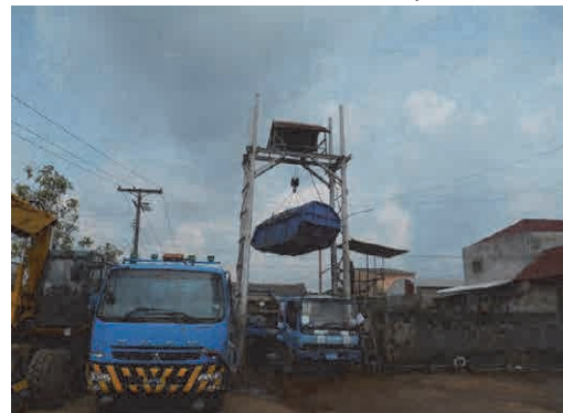
簡易ごみ積み替え設備
