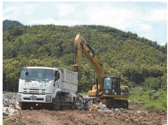
重機によるごみの移設
