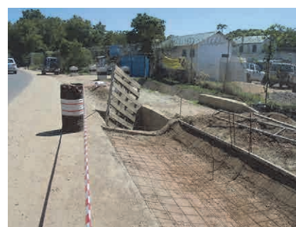
建設中の側溝 (Juba 市内)
