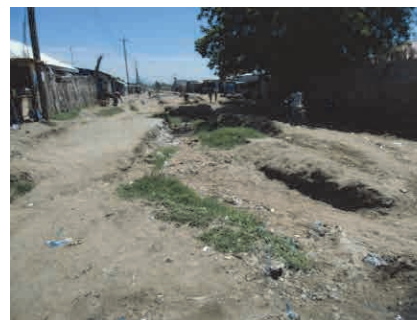
排水機能不良によるガリ侵食が発生した土砂道路 (Juba 市内)
