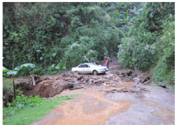
ナムサンへは山岳道路を通る。激しい降雨により、土砂崩れが発生し、道路が閉鎖されることもある。写真は土砂崩れ箇所でセダンがスタックしているところ。
