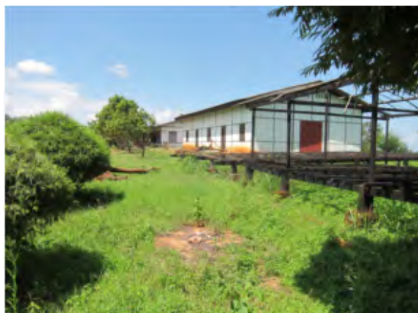
試験場倉庫（手前）奥には職員宿舎が見える
