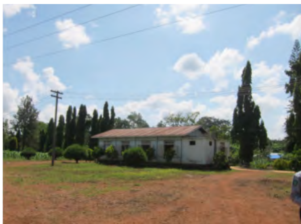
試験場の事務管理棟
