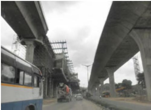
建設中のメトロ駅とフライオーバー
