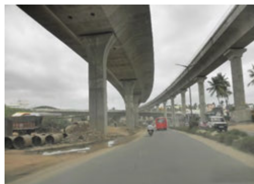
フライオーバーと立体交差
