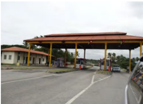
NICE Road 料金所
