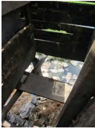
ラグーン上に建設されたトイレの内部
