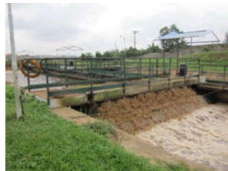
汚水処理場 - オキシレーションディッチ
