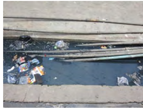
排水路内に設置された給水管
