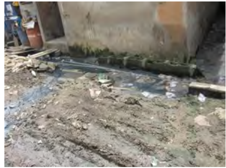
排水路の状況
