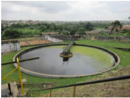
汚水処理場 - 最終沈澱池
