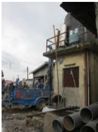
LMDGP で建設された井戸の改修工事
