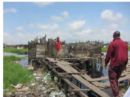
ラグーン上に建設されたトイレ
