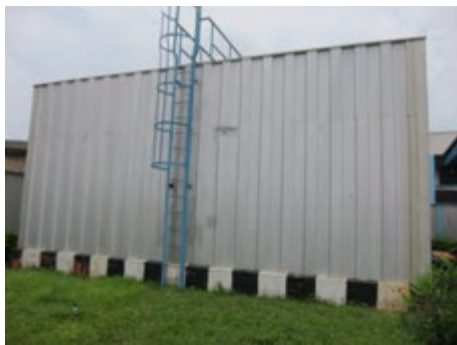
水公社の小型浄水場 - ばっ気タンク (鉄除去)
