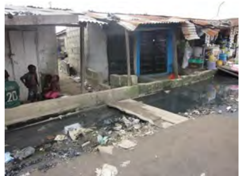
排水路の水位より低い家屋
