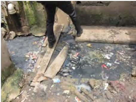
排水路の状況
