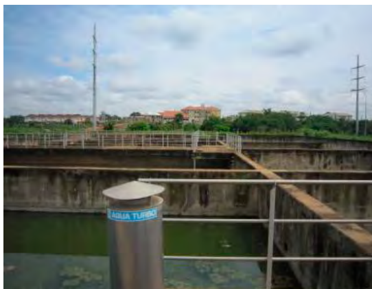
写真 4.2 Phase 2 の小規模下水処理
