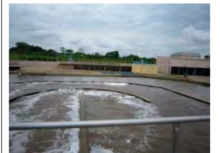
コンクリート水路型オキシデーション・ディッチ
