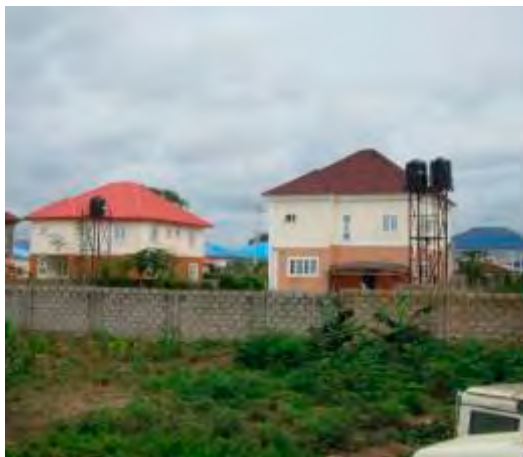
写真 3.2.1 個人住宅の簡易高架水槽
