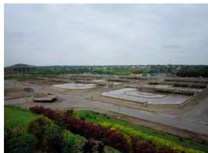
Wupa 下水処理場全景(処理能力: 132,000 m 3 /日)
