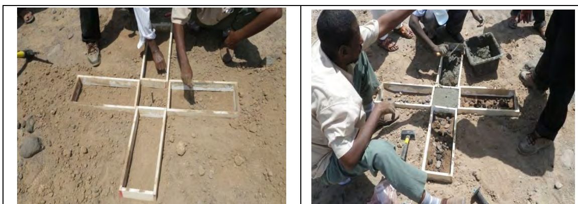
Figure 9 Mise en place des points d'orientation
