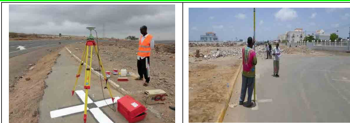
Figure 10 Observations GNSS (à gauche : Observation GNSS, à droite: Nivellement)
