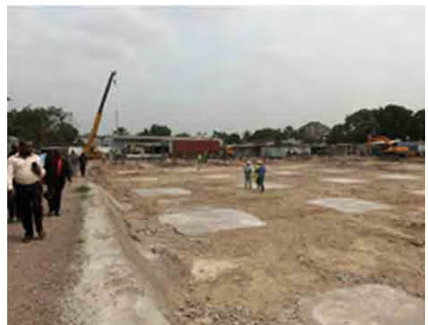
INPP キンシャサ校敷地内で進められている、 無償資金協力による校舎建設
