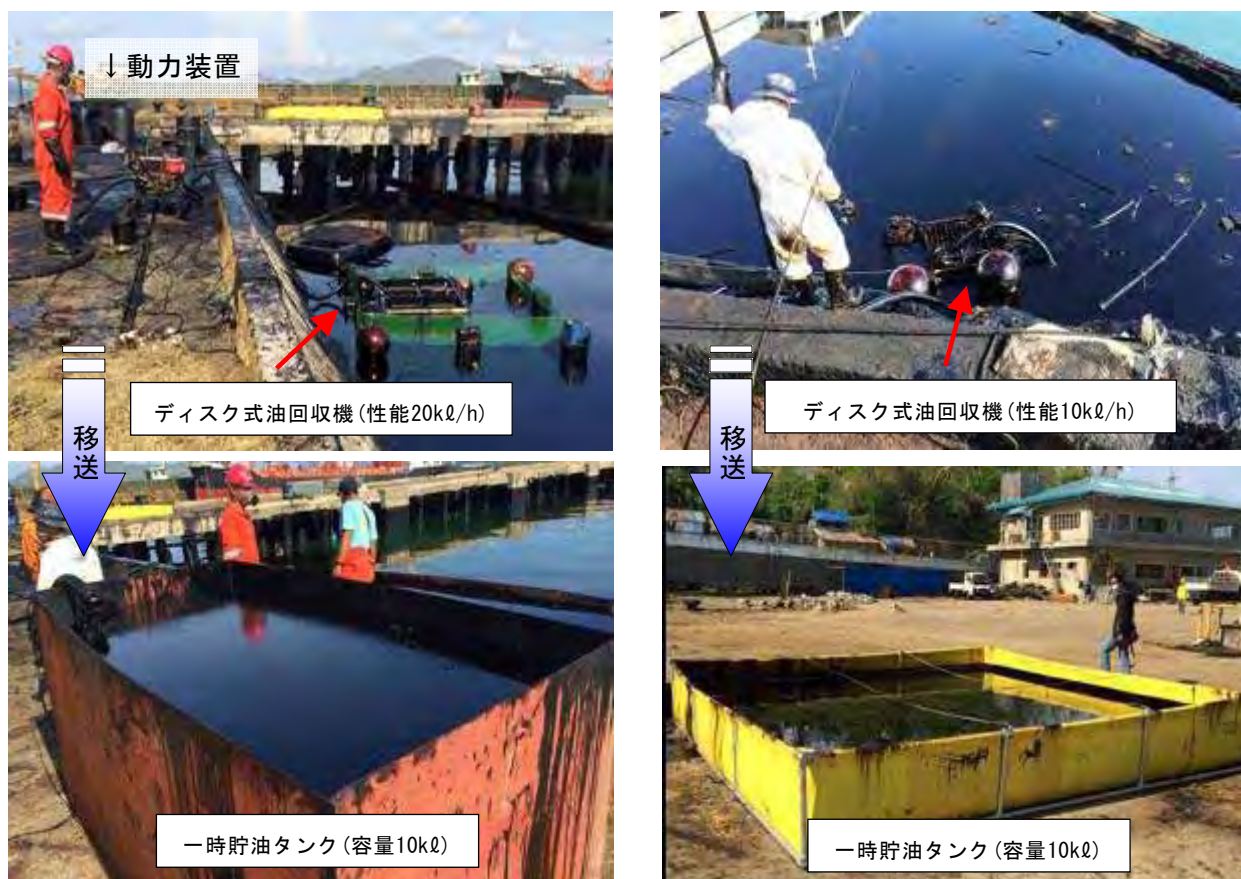
油回収機を用いた作業の様子
