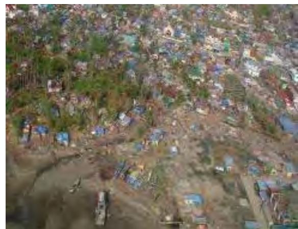
エスタンシア市街の被害状況
