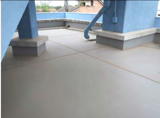
2011 年末～2012 年 3 月に実施された JICA のフォロー アップにて施工された 2 階屋上のシート防水
