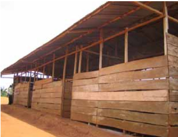
PTAにより建設されたヤウンデ郊外小学校 校舎外観
