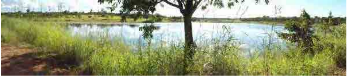
カンボンド溜池（推定貯水量30万 m^3 ） 乾期末の9月においても水位は満水位以下1m以下しか低下しない。
