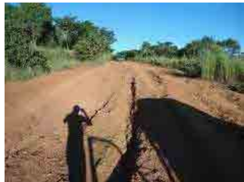
クイトーチカバ間の道路状況 傾斜区間が50%以上に及び、雨水によるガリ侵食が激しい。
