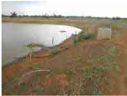
ザンビアにおけるサイホン施設 (溜池堰堤の上流側)
