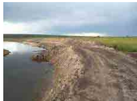
クケマ川右岸側の堰堤
