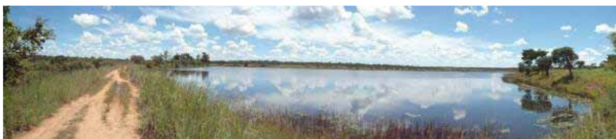
アルブフェラダム (推定貯水量300万m 3 ) 乾期末の9月においても水位は満水位以下1m程度までしか低下しない。
