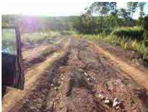
クイトーチカバ間の道路状況 傾斜区間が50%以上に及び、雨水によるガリ侵食が激しい。
