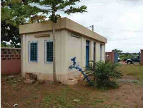
ダッサズメの井戸水源地。 管理棟内に圧力調整弁、流量計等がある。
