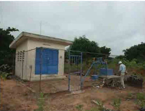
サベ市、Diho 村の村落給水井戸、過剰揚水で動水位が下がり、現在ほとんど稼働していない
