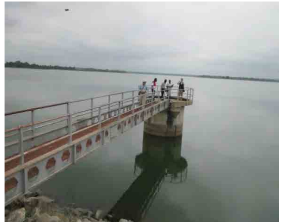
イロコダム余水吐き塔 2013年8月27日
