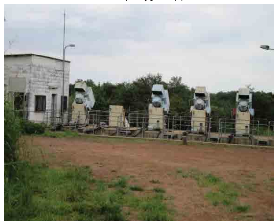
SUCOBE 揚水ポンプ場 2013年9月4日 4基の揚水ポンプのうち2基は予備
