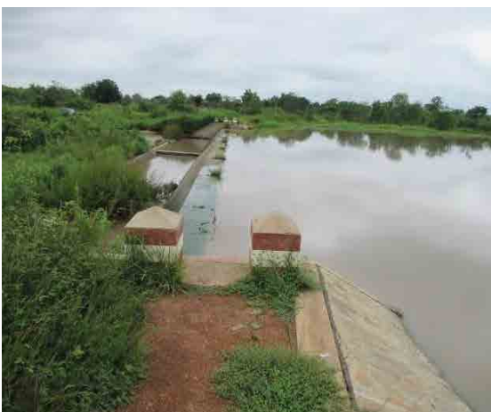
SOWE ため池 2013年9月4日 貯水量が十分でないため、灌漑には使用できない。
