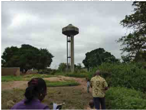
ダッサズメ市の高架水槽 75m 3 ×25m
