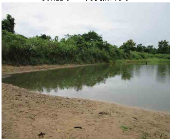
ALAFIA ため池 2013年9月5日 周りの土を集めて転圧しただけのアースダム。
