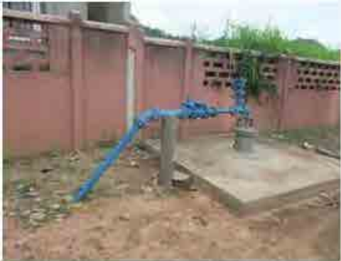
ダッサズメ市、SONEB の Kpekoute 井戸、過剰揚水により乾季に水位が下がり泥が混じる
