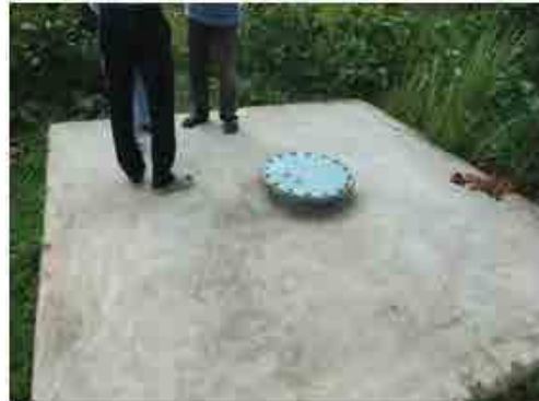
ダッサズメ市、SONEB の Arigbokoto 試掘調査井、掘削時の揚水量は 15m³/時を超える
