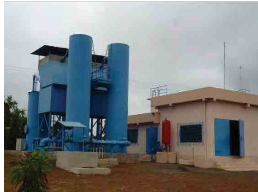
ゴベ浄水場。サベ市からおよそ 10km 西方に位置する急速濾過式プラントで、生産量は約 50m 3 /時。
