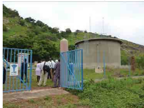
サベ市内配水池。
