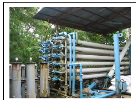
写真-6 Mactan Rock 社の膜処理
