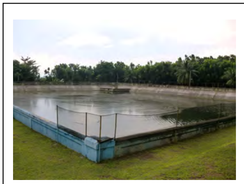
写真-4 Tisa 浄水場（緩速ろ過池）
