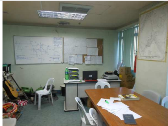
写真-12:中央監視制御装置の予定部屋
