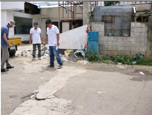
写真-11:配水ブロック計測マンホール
