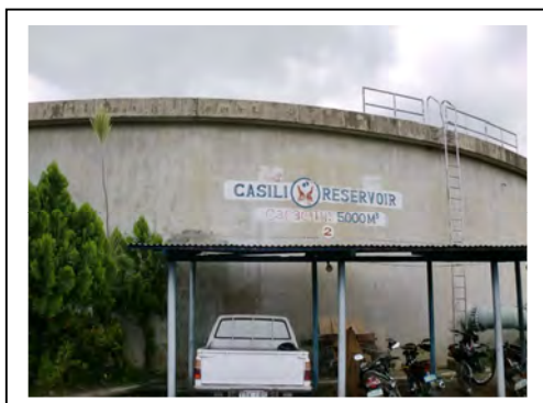
写真-2 Casili 2 配水池
