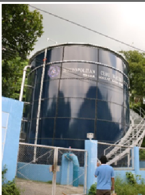
写真-5:B. C. ホームズ配水池 2012年にバランスタンクの機能(夜間に貯留し日中に配水する)を有する配水池が建設された。今回は機械式の水位計のみが設置されている。
